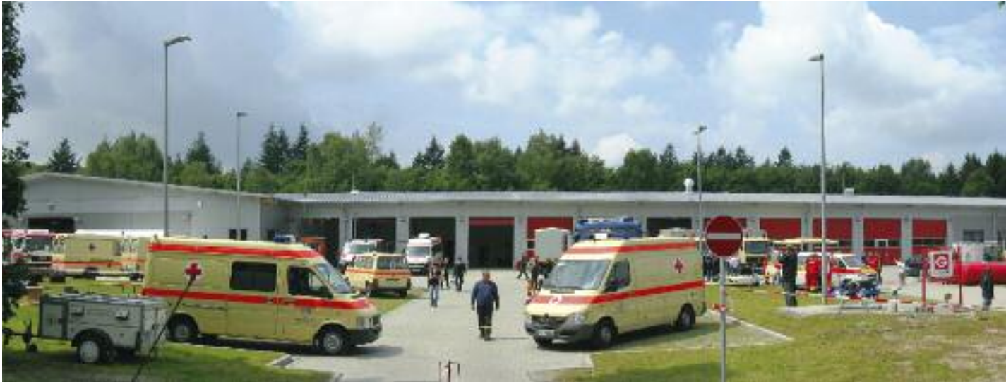
Das neue Katastrophenschutzzentrum Münsterdorf, rechts im Hintergrund die Technische Kreisfeuerwehrzentrale, rechts im Vordergrund die Rettungswache.
